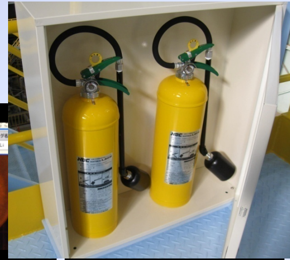
(d) After fire extinguishing
